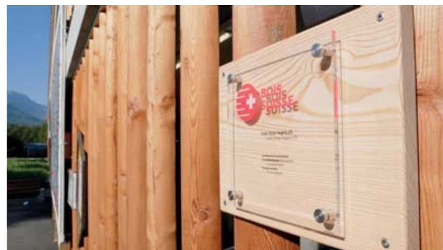
Le bois valaisan peut être un atout gagnant en construction. La preuve avec le parking couvert de l'hôpital de Sion qui a reçu le label Bois suisse en septembre dernier. LDD
